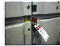
รูปแสดงการตัดแยกไฟฟ้าที่หน้าอาคาร (Substation)
